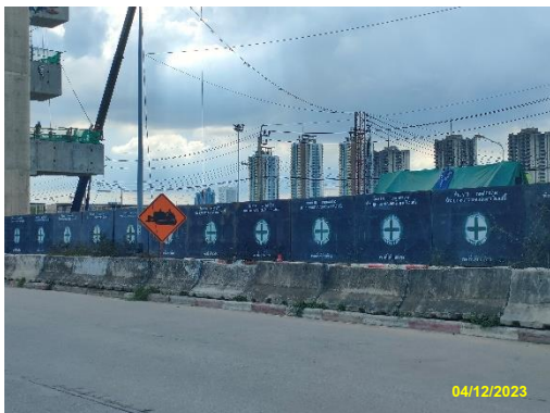
รูปที่ 2-16 การติดตั้งกำแพงคอนกรีต พร้อมรั้วผ้าใบทึบ ความสูง 2.0 เมตร
