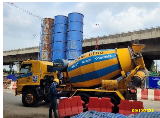
รูปที่ 2-17 การใช้คอนกรีตผสมเสร็จ
