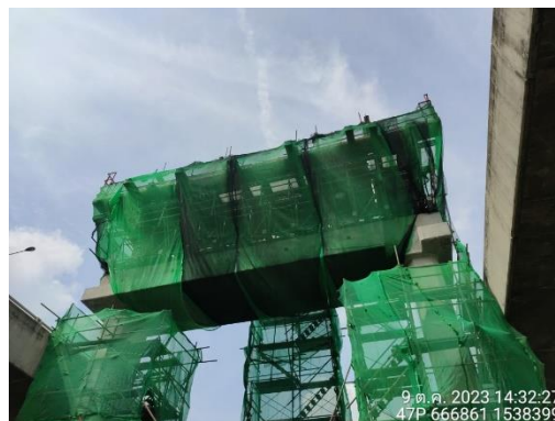
รูปที่ 2-9 การติดตั้งตาข่าย (Safety Net)
