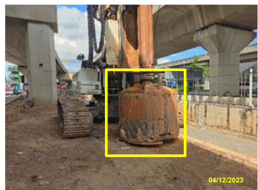
เสาเข็มเจาะหน้าตัดกลม (Circular Bored Pile)
