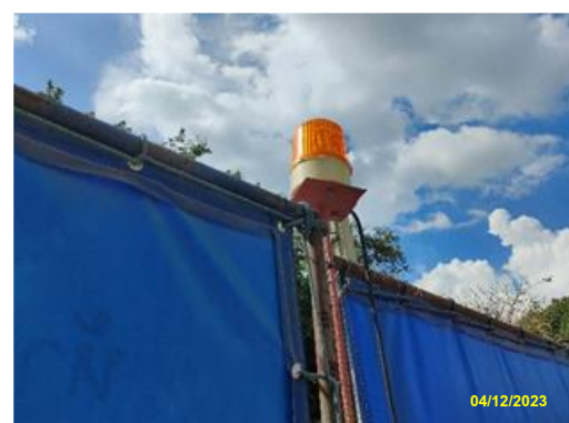
รูปที่ 2-31 การติดตั้งไฟกะพริบ
