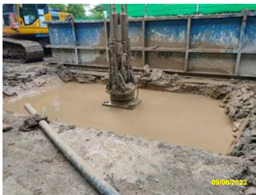
เสาเข็มเจาะหน้าตัดเหลี่ยม (Barrette Pile)
