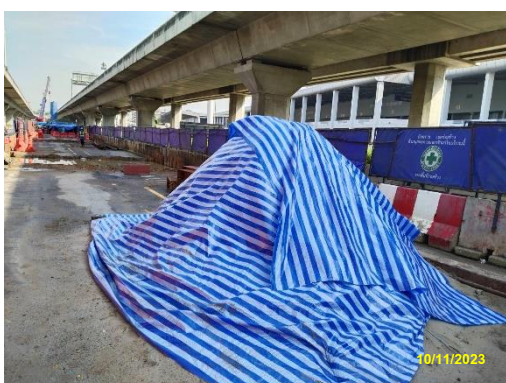
รูปที่ 2-22 การใช้ผ้าใบปิดคลุมกองดิน/กองเศษวัสดุ
