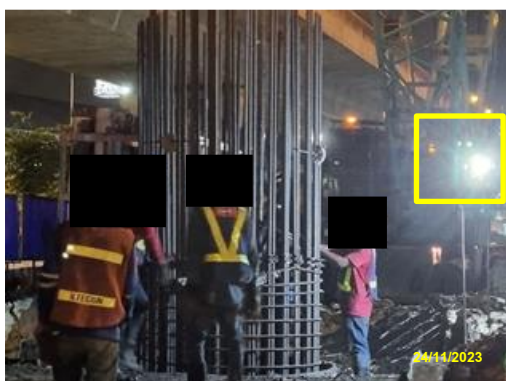
รูปที่ 2-41 การติดตั้งไฟส่องสว่าง ภายในพื้นที่ก่อสร้าง
