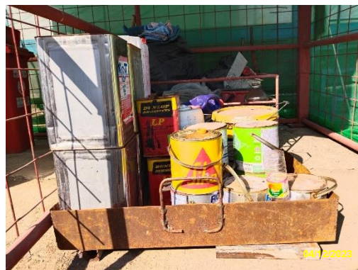
รูปที่ 2-10 การจัดเตรียมภาชนะรองรับคราบน้ำมันและสารเคมี
