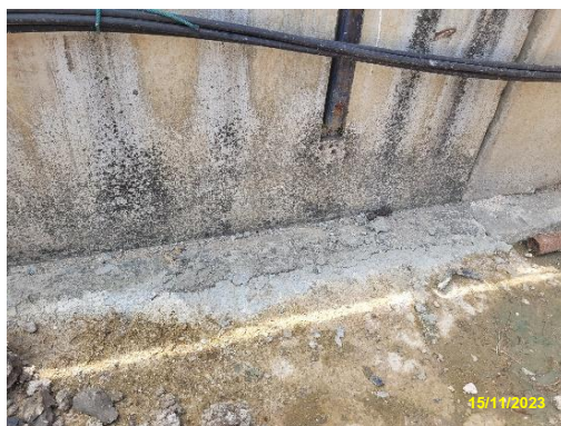
รูปที่ 2-11 การขยายขอบกำแพงกันพื้นที่ก่อสร้าง
